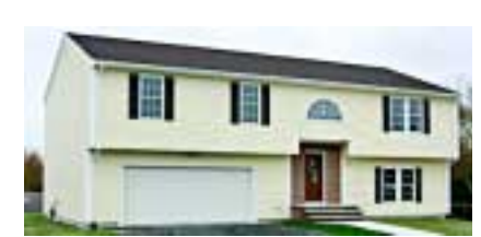
Casas novas em construção
